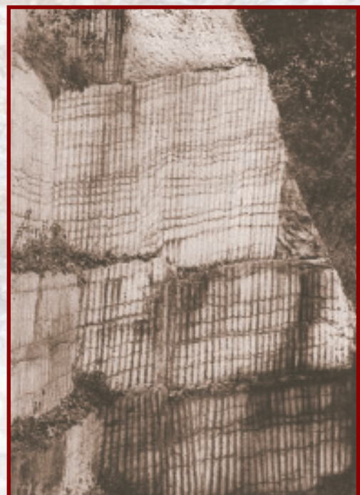
Loch-an-Loch-Abbaumethode, Schnöllbruch; Foto: Alois Kieslinger, 1964
